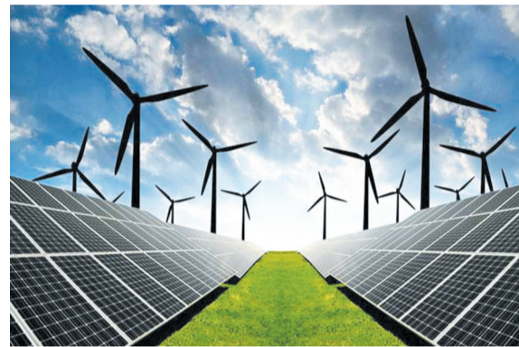
光伏发电。(资料图片)
